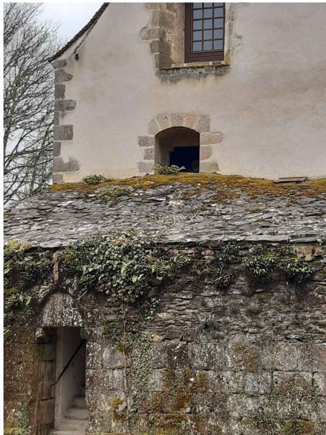
De toegang van de kluizenaarswoning
